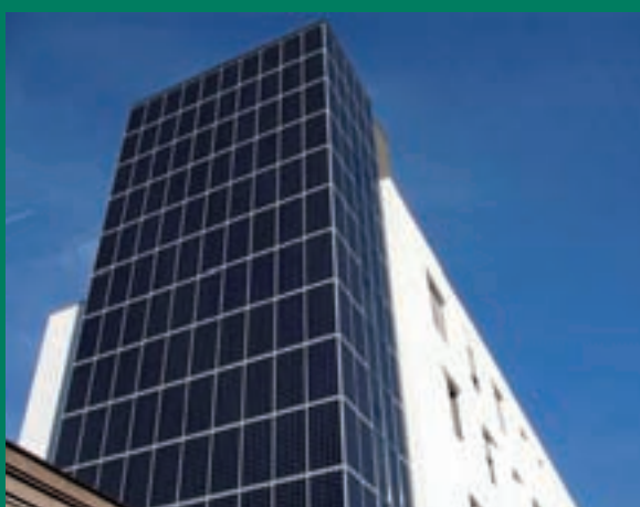
Installazione sulla facciata di un edificio
