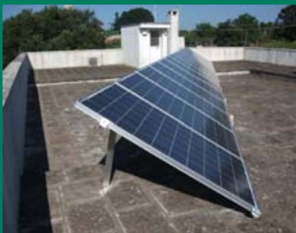
installazione sul tetto - copertura piana
