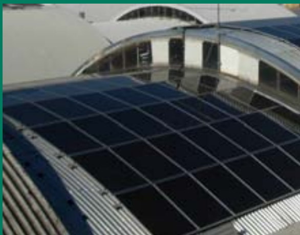
installazione su tetto - copertura curva
