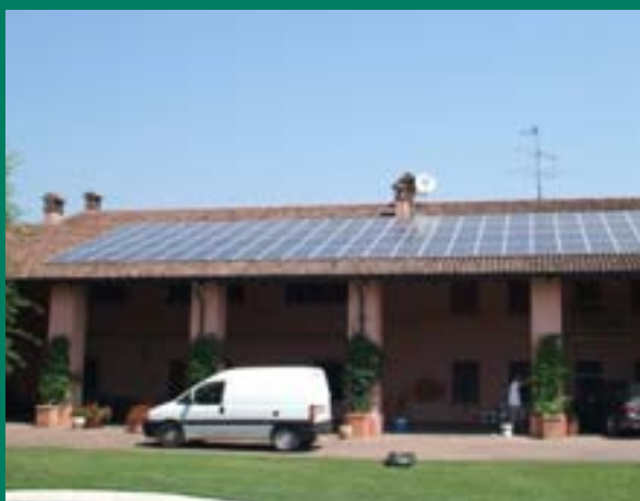
installazione su tetto - copertura a falda
